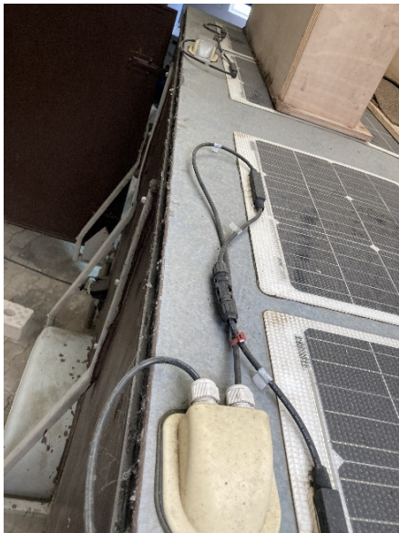
Dachmodulverschaltung
