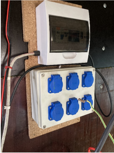
AC Stromkasten und Mehrfachsteckdose Versorgung Camp
